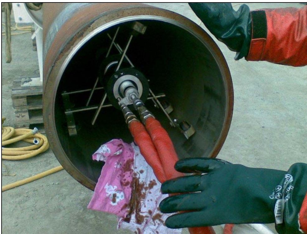
Figur 8 - Voksevogn klargjort for voksing av 16" rør
