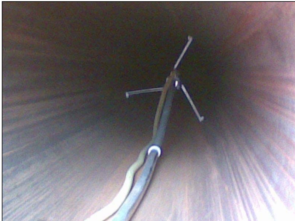
Figur 7 - Voksevogn i 36" rør med slanger og "stake" rør påmontert
